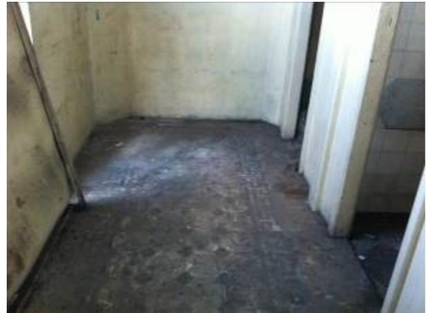
Las áreas mostradas en las fotografías son las ubicadas en áreas de losa de entrepiso a intervenir por encontrarse con daños estructurales. La Contratista deberá realizar un levantamiento y registro fotográfico del diseño original del mosaico en piso, para posteriormente suministrar e instalar el piso con las mismas características del existente, conservando la identidad del inmueble.
