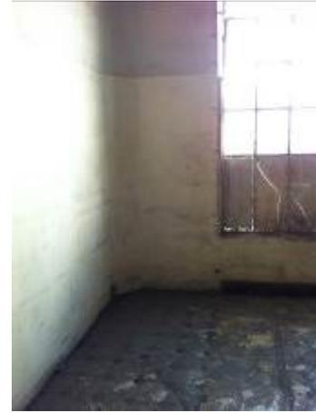
Fotografías de piso tipo mosaico sobre losa de entrepiso con sótano, la cual será demolida debido al estado de deterioro de la losa. La Contratista será responsable de suministrar e instalar piso igual al existente.
