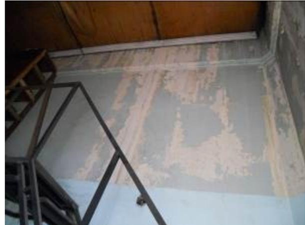
(fotografía izquierda) Losa de entrepiso de segundo nivel y azotea, la cual se demolerá y construirá nueva. (fotografía derecha) pared en segundo nivel que presenta agrietamientos y humedad a reparar.
