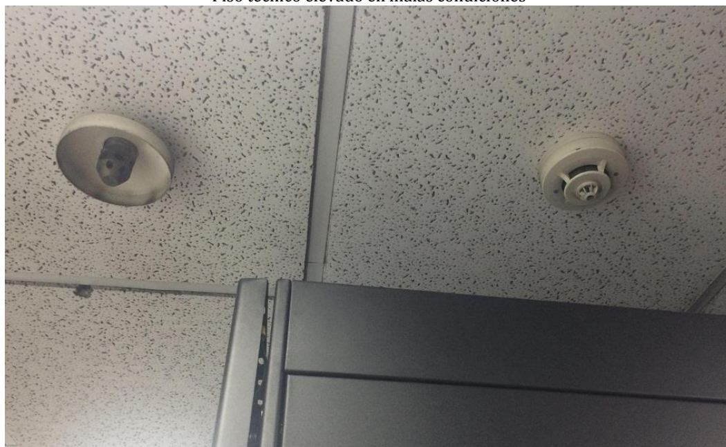
Sistema de emergencia contra incendio fuera de uso y sensores de temperatura en mal estado
