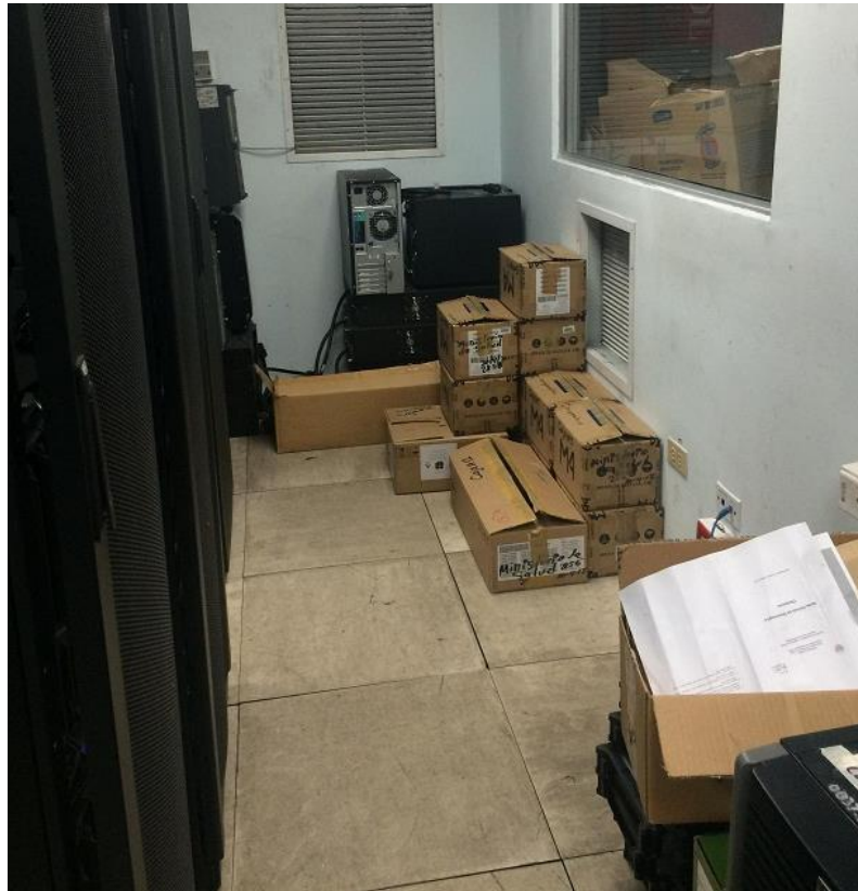
Sala de servidores principal piso desnivelado, utilizado como bodega
