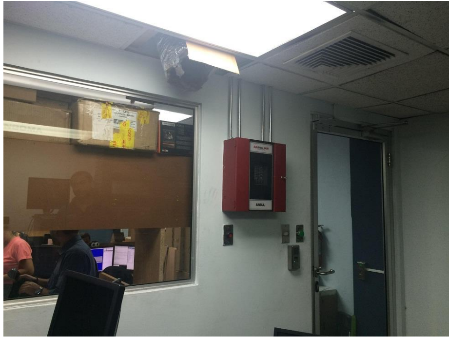
Sistema de inyección y extracción de aire acondicionado en mal estado
