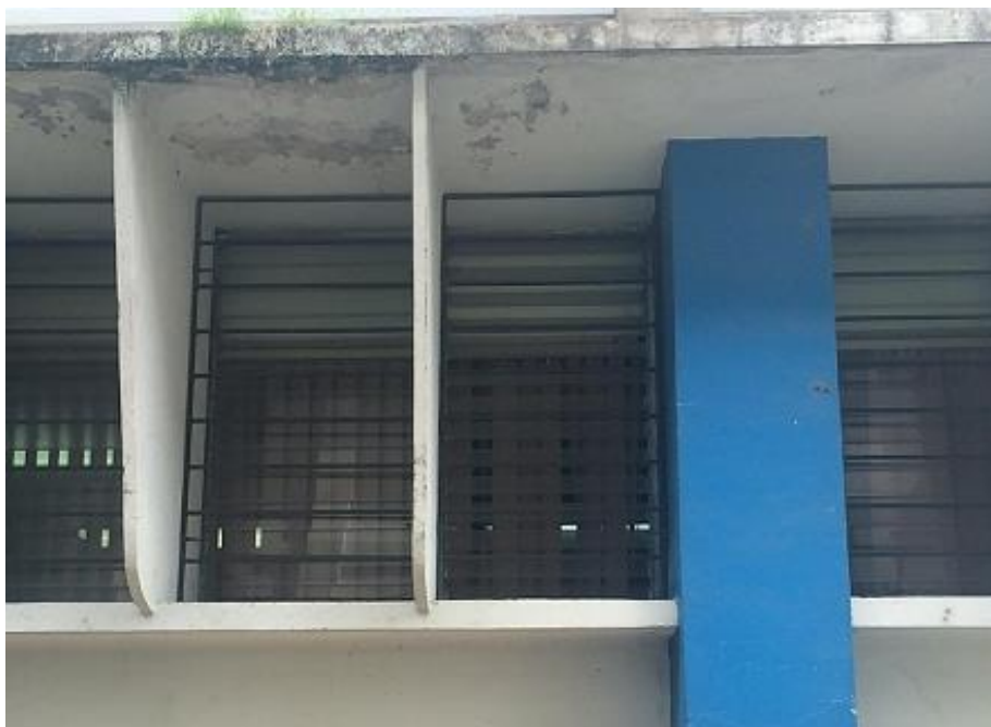
Ventanería en mal estado, no cierran y las defensas metálicas faltan piezas
