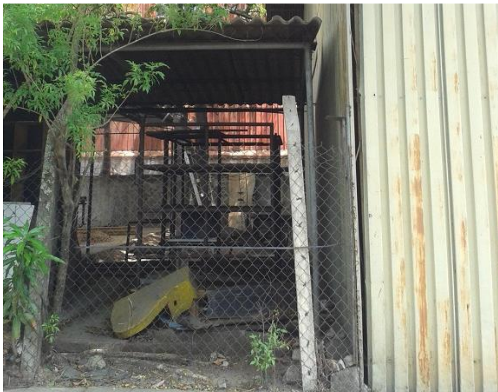
Área para la construcción de bodega de la DTIC y sala de facilitadores
