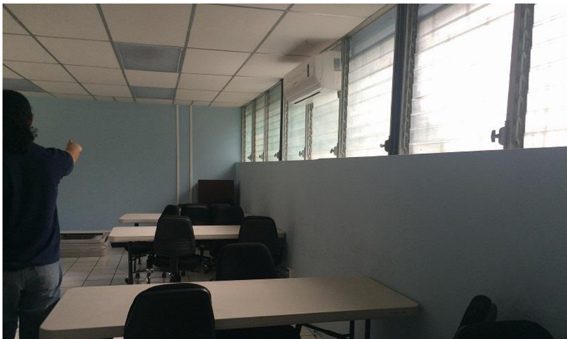
Mejora de climatización en aulas existentes por falta de cortinas verticales y falta de capacidad de equipo de aire acondicionado en aulas de capacitación
