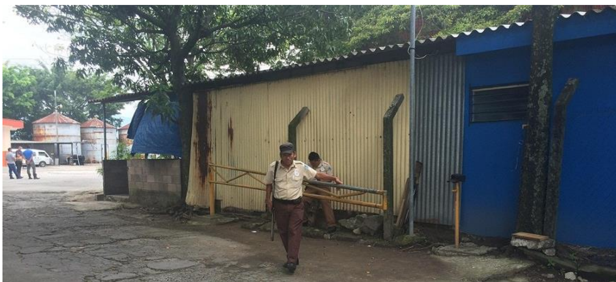
Vista de pared de lamina en área de comedor en mal estado (color amarillo)
