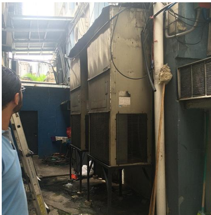
Equipos obsoletos y fuera de uso en espacios para utilizar nuevos equipos
